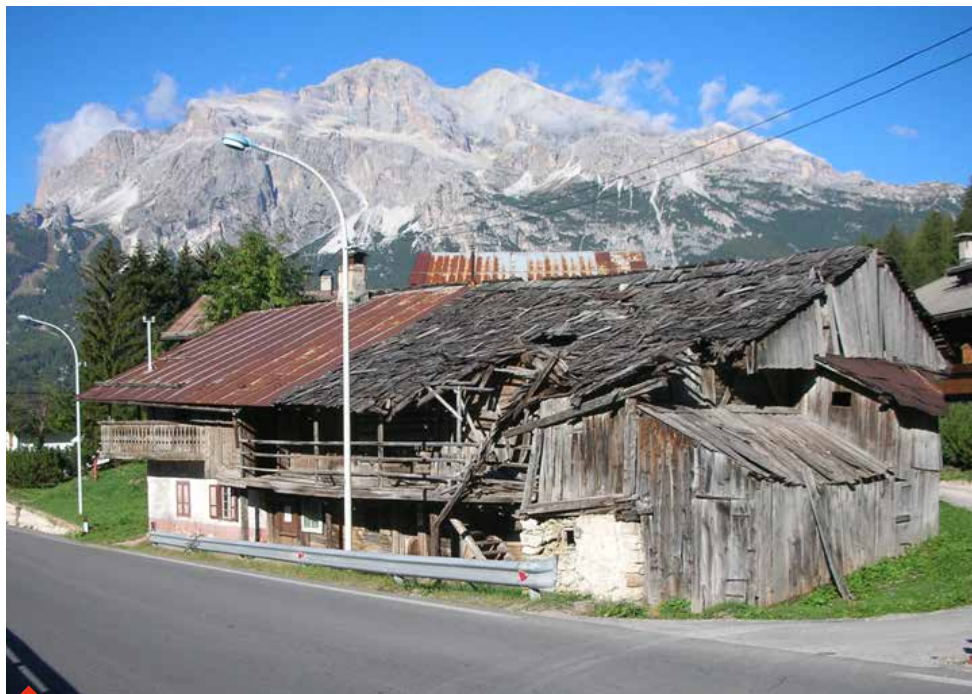
COM'ERA L'edificio rustico prima dell'intervento di restauro
