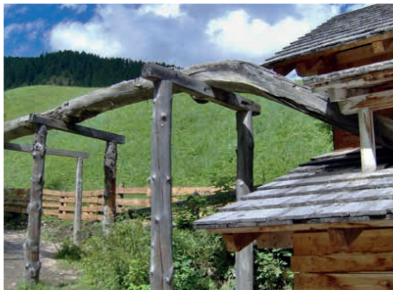
Impiego di un tronco curvo per raccordare il flesso di una canaletta di un mulino ad acqua in Val Badia
