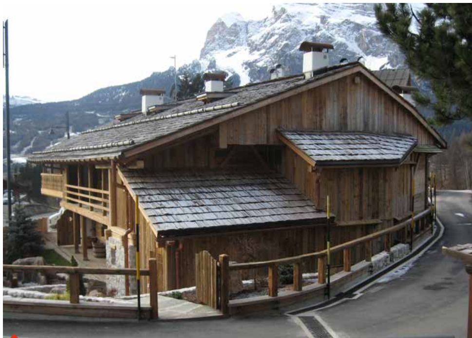
COM'È Come si presenta oggi il complesso che ospita cinque unità abitative
